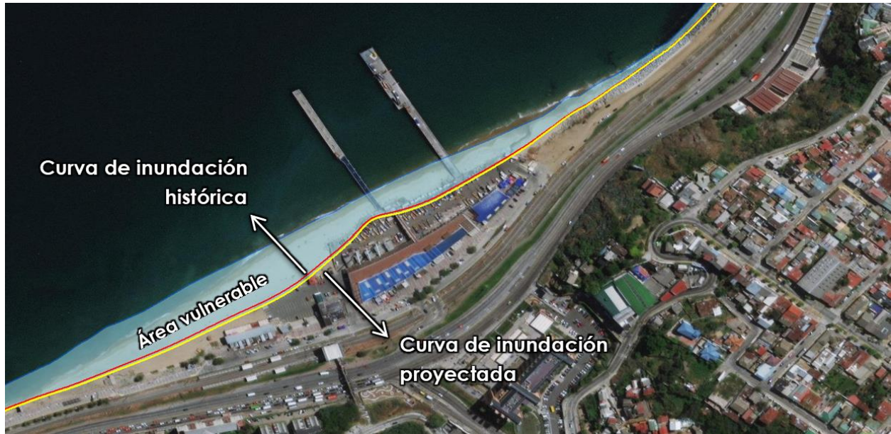
Figura 10: Ejemplo de la construcción del área vulnerable a partir de la curva de inundación proyectada con el escenario RCP 8.5 en Caleta Portales, Valparaíso.
