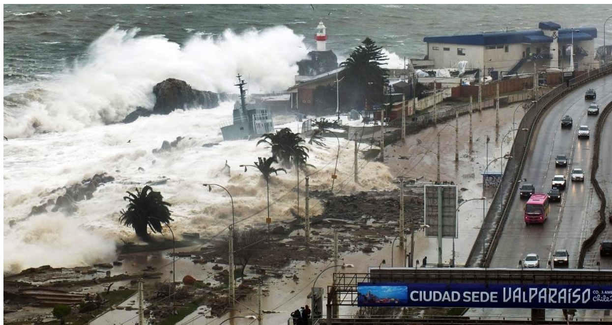
Figura 4: Arriba: Sobrepaso en Av. España, Valparaíso, debido al temporal del 8 de agosto de 2015 (Winckler et al., 2017). Producto de las olas, se destruyó la defensa y se cortó la línea del metro entre Valparaíso y Limache. El flujo llegó incluso a la avenida, lo que se evidencia en el desplazamiento de las barreras tipo New Jersey en la esquina inferior derecha de la foto.
