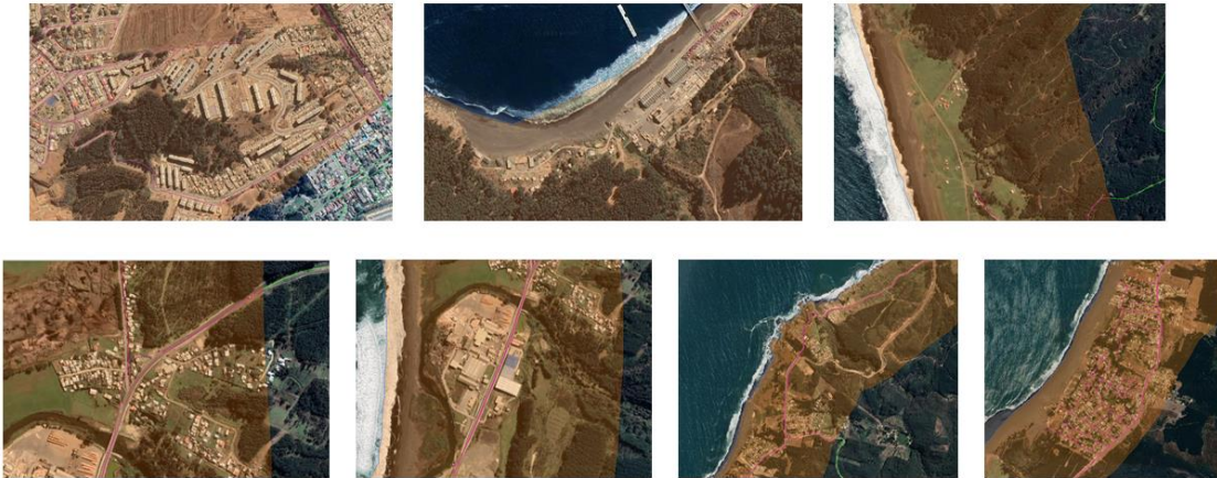
Figura 146: Falta de caminos en la Comuna de Constitución.
